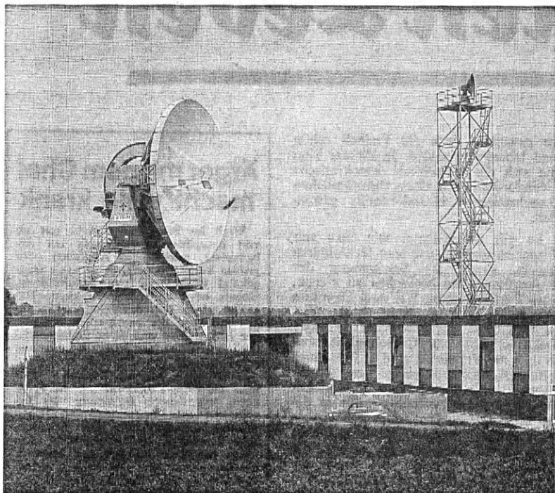
Nachrichtenverbindungen für die Zukunft werden mit dieser Anlage in Leeheim bei Darmstadt (BRD) untersucht. Es handelt sich um die Parabolantenne einer sogenannten „Erdfunkstelle“, mit der Frequenzbereiche oberhalb 10 GHz erprobt werden, da die bisher gebräuchlichen Hochfrequenzen der Fernmeldesatelliten bereits ausgebucht sind. Allerdings sind bisher die störenden meteorologischen Einflüsse noch zu stark dpa-Bild
